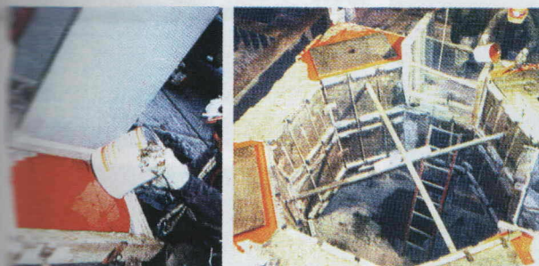
Obra: Cimentación de Chancadoras en Toquepala y Cuajone - Southern Perú
